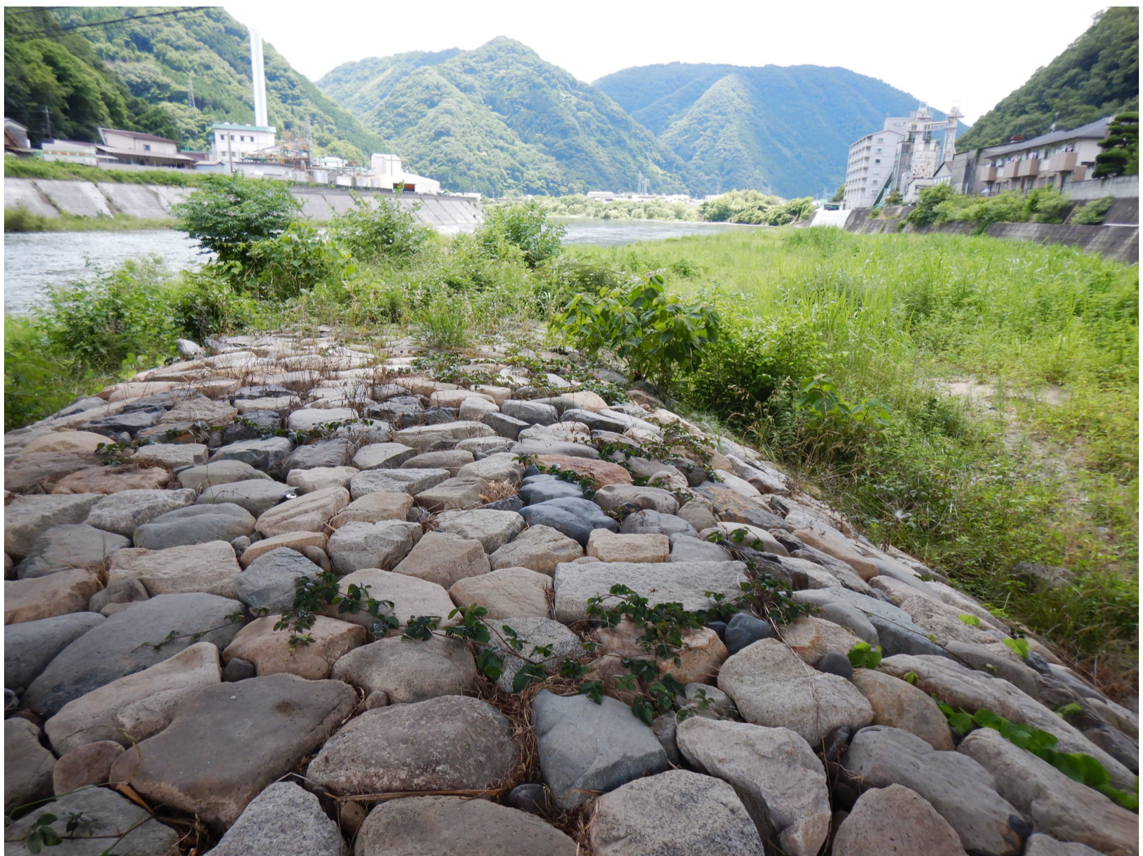
高梁市落合町近似地先（落合橋、一級河川高梁川右岸）
