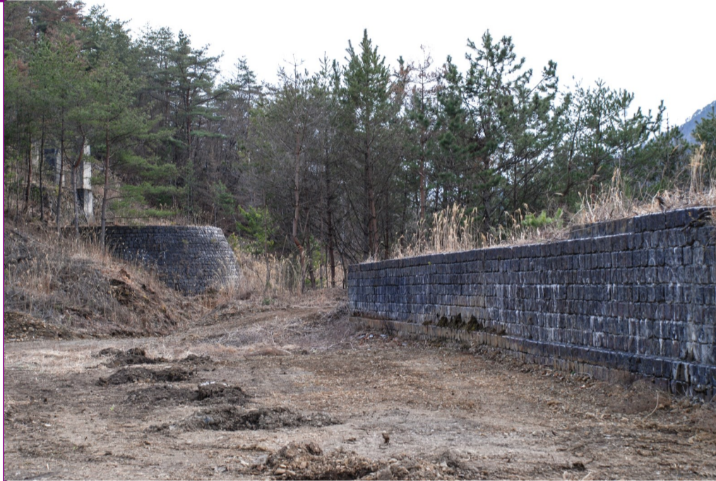
鉱滓煉瓦で造られた沈殿池(右)とシックナー
